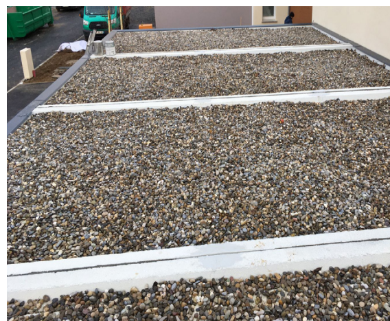
Acrotère en béton périphérique
