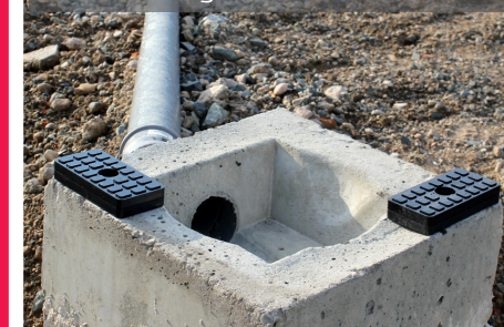
Exemple de fondation par plots avec drainage
